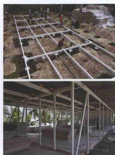
6 结构底框和预埋件的预拼装
