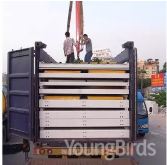
| 结构单元构件的打包计划和实景 |
