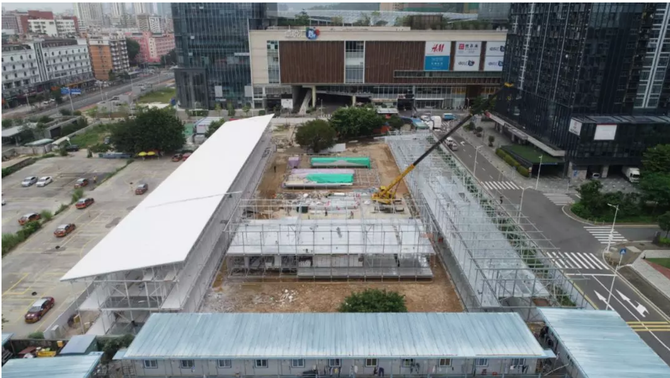
深圳梅丽小学临时校舍建设现场
