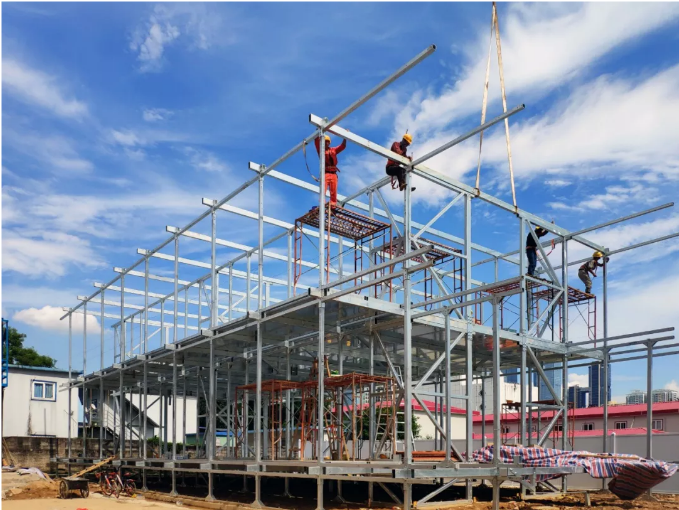
深圳梅丽小学临时校舍建设现场
