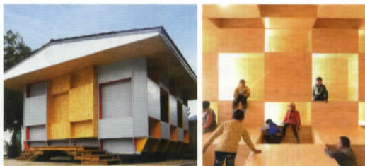
2015年，朱教授及其團隊在甘肅省的偏遠農村搭建了多個「童趣園」，為當地千多名因缺乏教育資源提供教育機會和嬉戲空間。童趣園採用方格形狀的基本單元，有如米斗般的凹凸空間高低錯落，將戶外的兒童遊戲引入室內。
