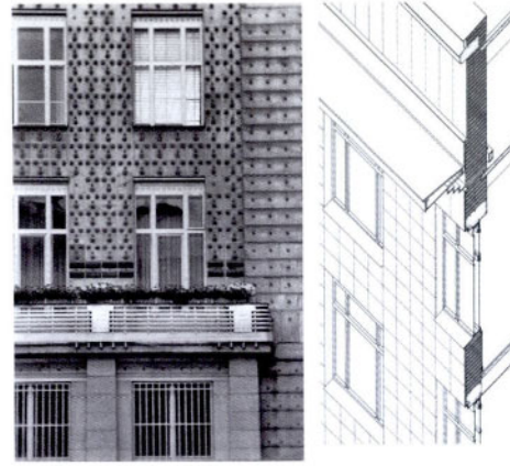
3 邮政储蓄银行 (维也纳, 奥托·瓦格纳, 1894-1902) 左: 立面局部; 右: 外墙构造
