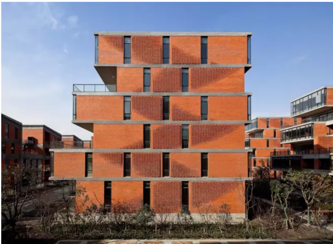
松江名企艺术产业园区，上海. 图片致谢 Archi-Union Architects
