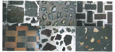
利用旧砖瓦、山石、卵石制成的各式肌理水磨地坪
