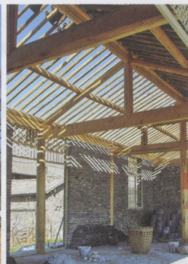
9 云南民居中被砖墙稳定的木框架
