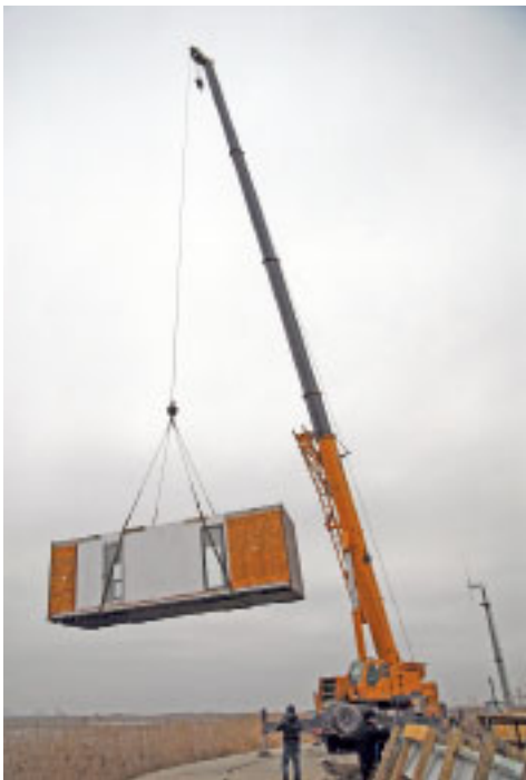
3 现场吊装过程
