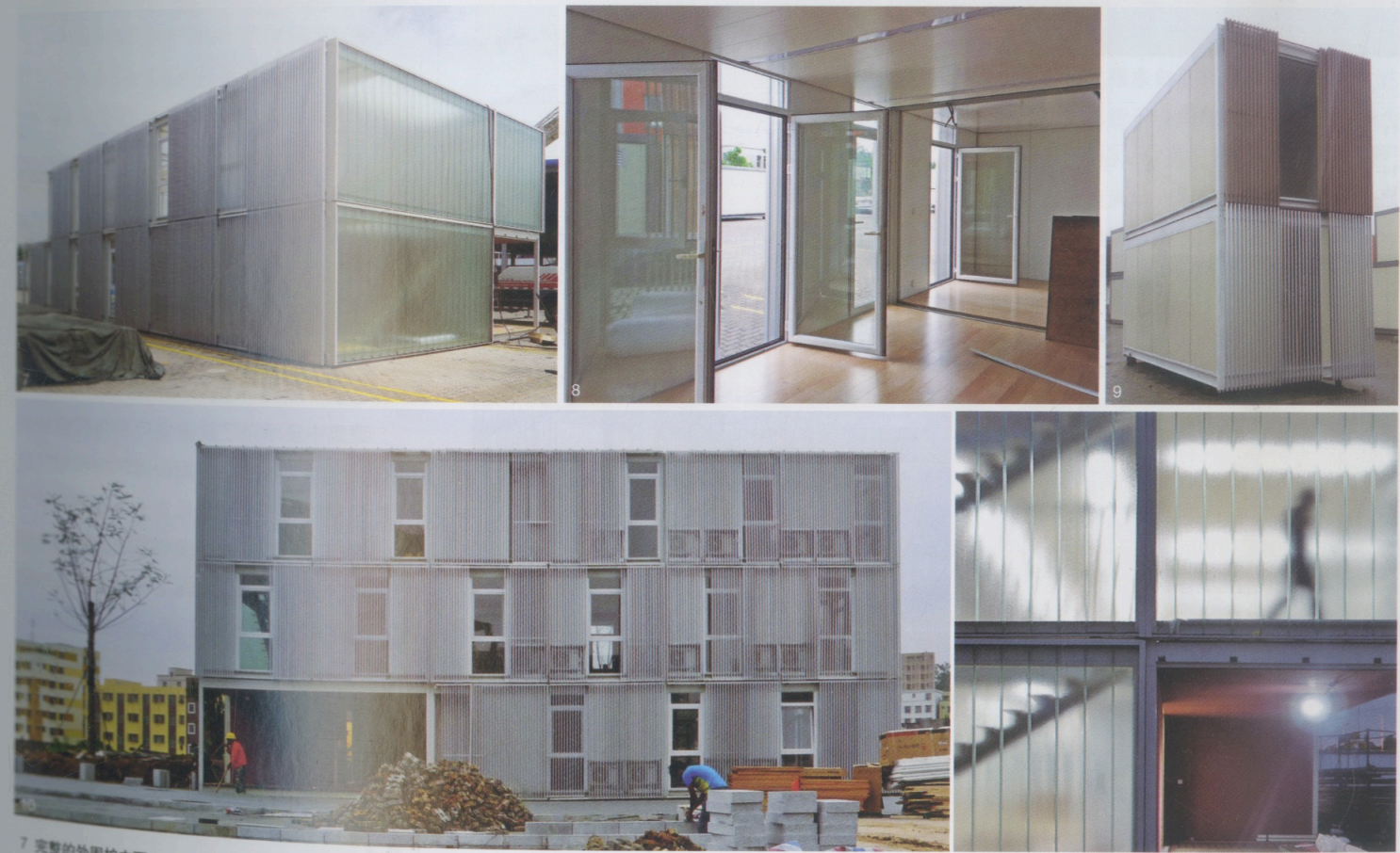
7 完整的外围护立面 8 墙面开口自然采光 9 木材与铝材的试样比较 10 半透明且富变化的立面表皮
