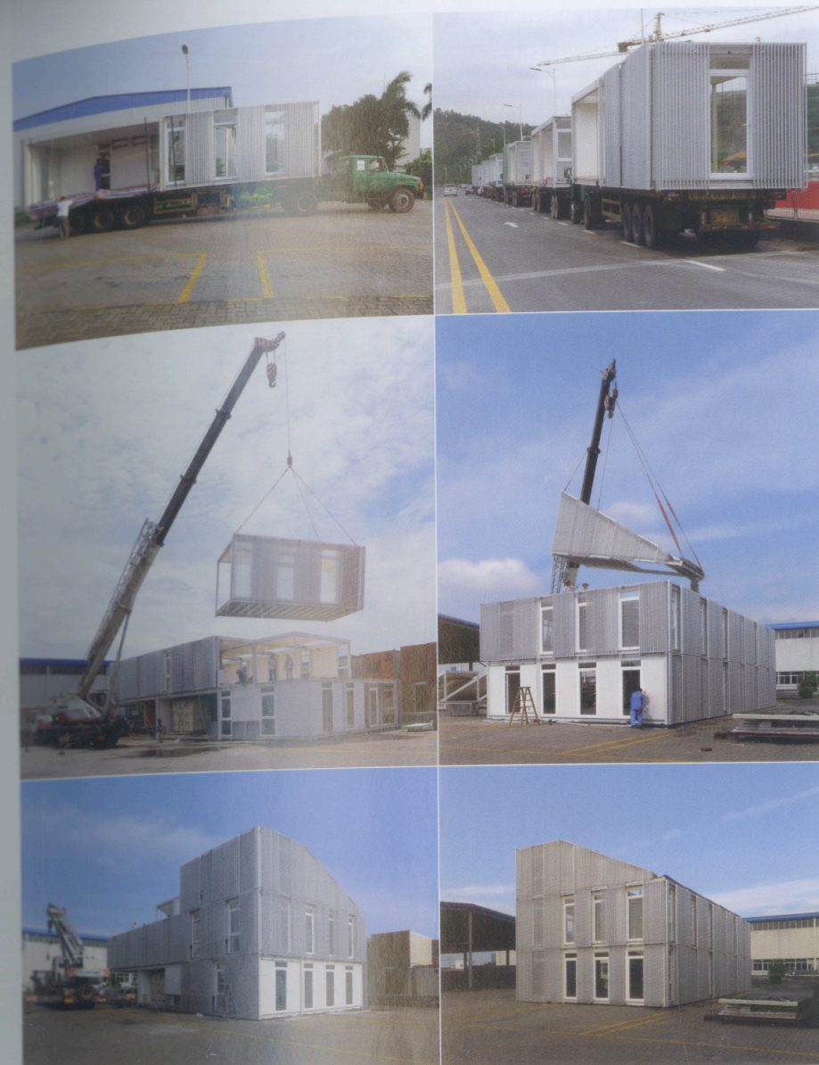
16 箱型模块的运输与工厂内的试吊装
